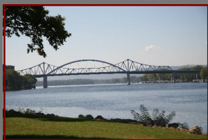
Cass St. Bridge, La Crosse, WI
