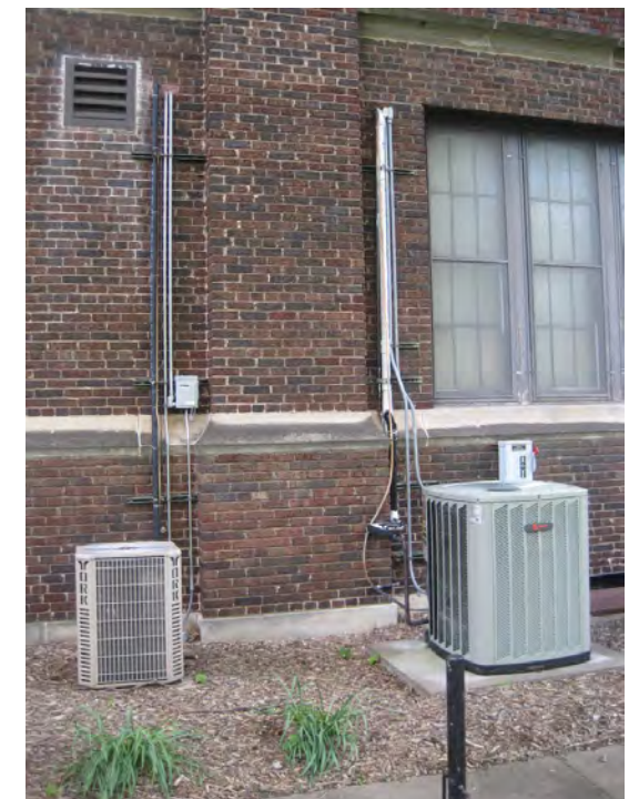
M-08-DX FAN COILS ACCU
